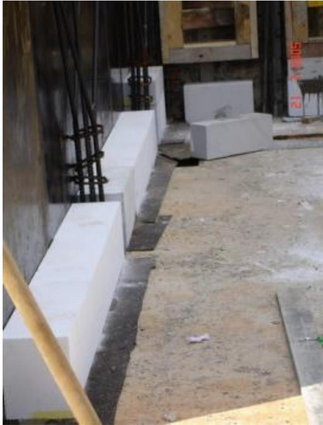
Abbildung 12: Bewehrung Stahlbetonhöcker, daneben 2 Lagen Porenbetonsteine [Schöberl & Pöll OEG]
