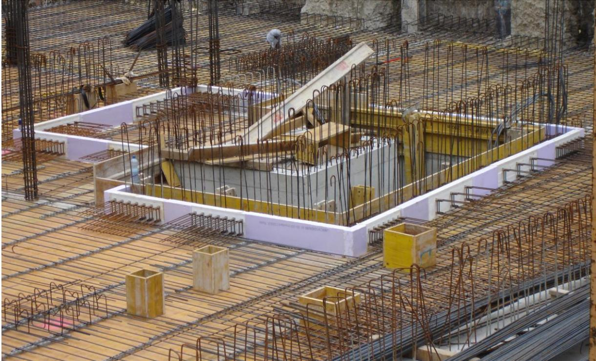
**Abbildung 2: „warme Hülle“ Stiegenhaus Decke über Tiefgeschoss [Schöberl & Pöll OEG]**
