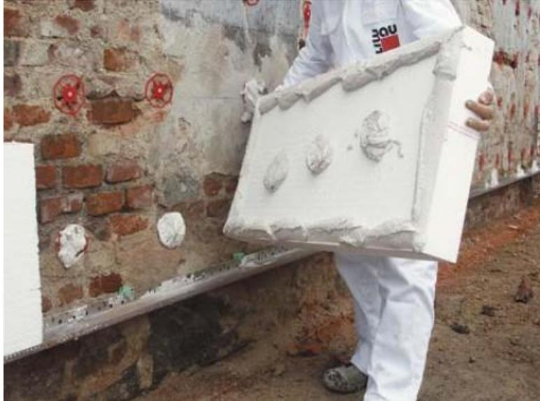
Abbildung 31: Klebeanker [Quelle: Baumit]
