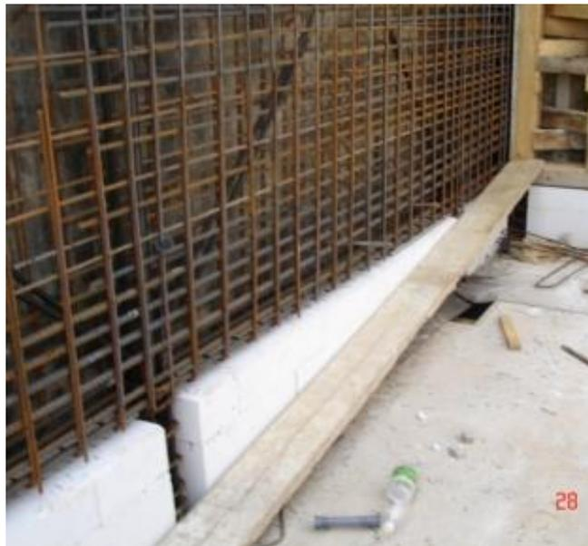
Abbildung 13: Oberhalb der Stahlbetonhöcker und des Porenbetons wird die Wand bewehrt [Schöberl & Pöll OEG]
