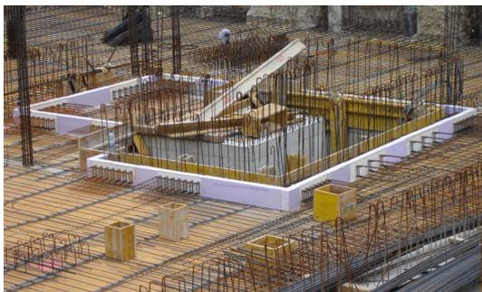
Abbildung 38: „warme Hülle“ Stiegenhaus Decke über Tiefgeschoss [Schöberl & Pöll OEG]
