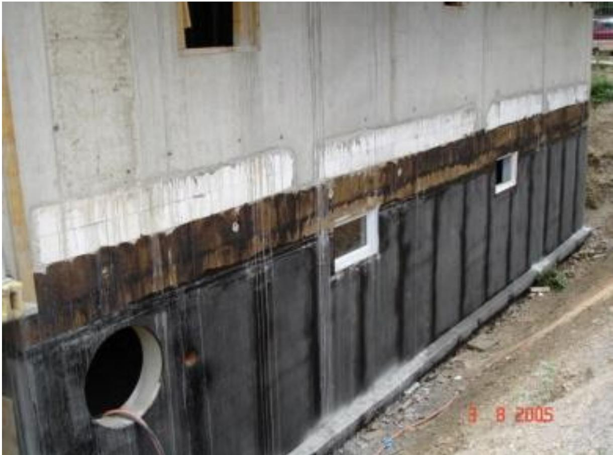
**Abbildung 14:** Oberhalb der Schwarzabdichtung der Tiefgarage sind die Stahlbetonhocker zwischen den weißen zweilagigen Porenbetonsteinfeldern zu sehen. [Schöberl & Pöll OEG]
