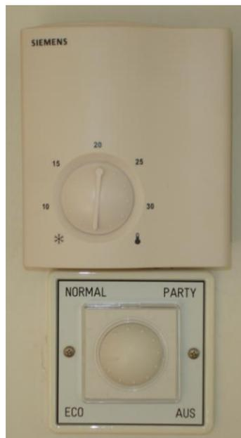
Abbildung 22: Volumenstromregelung und Thermostat [Schöberl & Pöll OEG]
